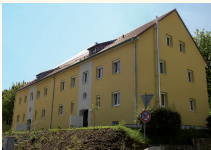
Schlesierstr. 4 und 6 in Kelheim vor und nach der Sanierung.
