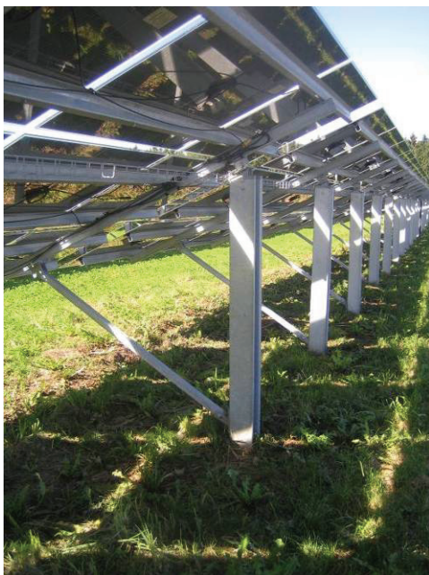
Abb. 2: Gründungsoption eingerammte Stahlprofile bzw. eingerüttelte Stahlrohre (Bildquelle: LfU)
