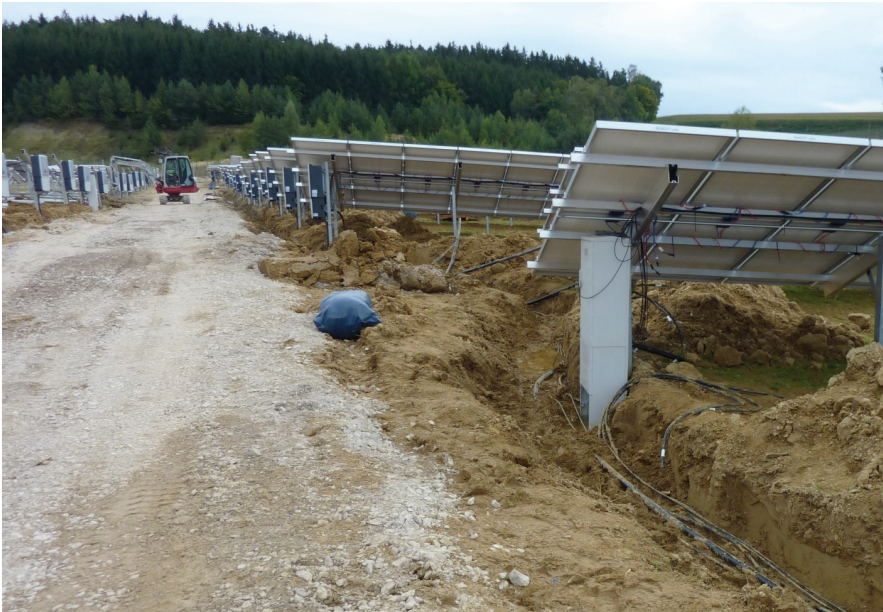
Abb. 1: Errichtung einer Freiflächenphotovoltaikanlage (Bildquelle: Hallertauer Handelshaus GmbH)
