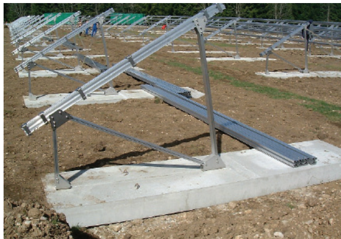
Abb. 3: Gründungsoption Streifenfundamente (Bildquelle: SolarWorld AG)
