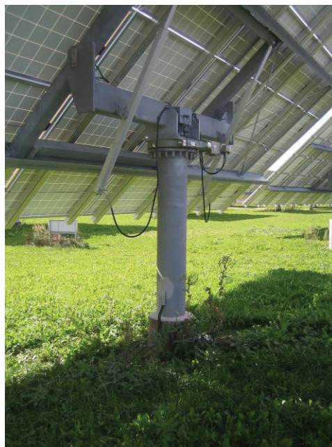
Abb. 2: Gründungsoption eingerammte Stahlprofile bzw. eingerüttelte Stahlrohre (Bildquelle: LfU)
