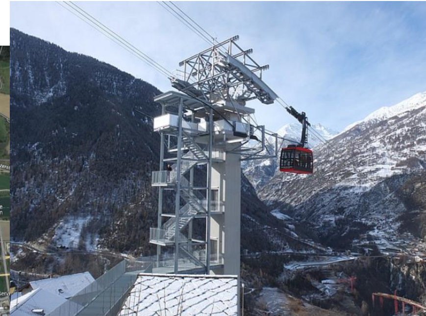
Ausführung einer Zwischenstation bei einer Pendelbahn Quelle: Damian Bumann
